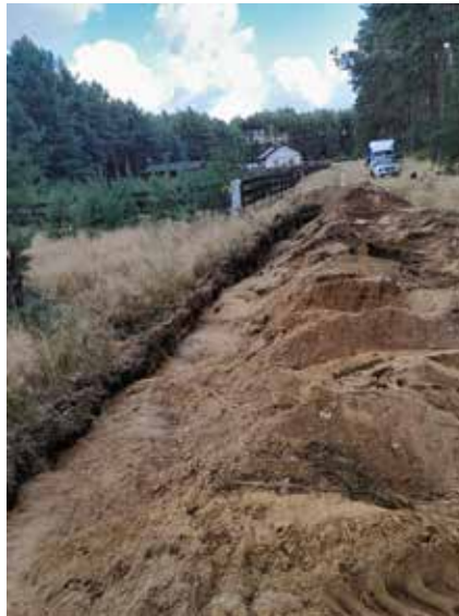
Budowa sieci wodociągowej w Kwiejcach
