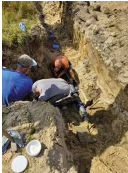
Budowa sieci wodociągowej w Pęcownie
