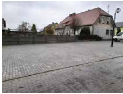
Budowa chodnika i parkingu na targowisku w Drawsku
