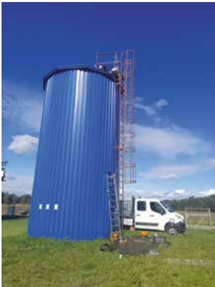
Czyszczenie zbiorników retencyjnych na SUW w Drawsku Abisynia
