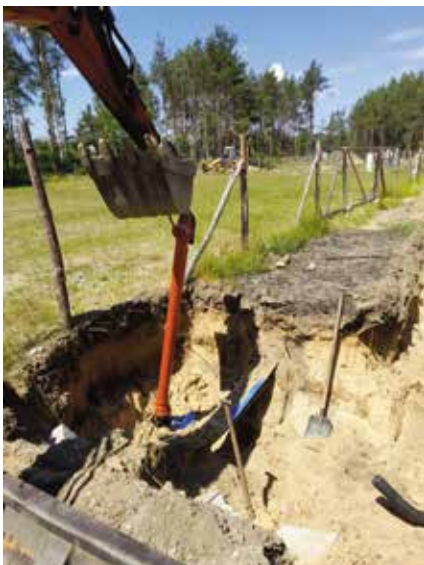
Budowa sieci wodociągowej w Drawskim Młynie
