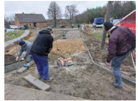
Budowa chodnika i parkingu w Kawczyń
