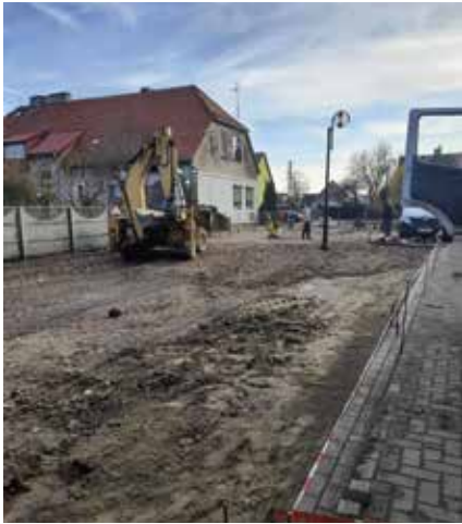
Budowa chodnika i parkingu na targowisku w Drawsku
