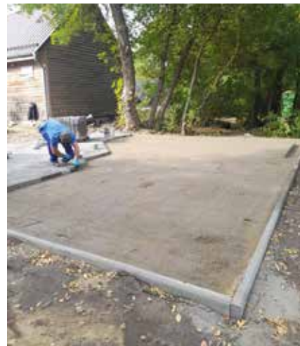
Układanie kostki brukowej pod wiatę w Marylinie
