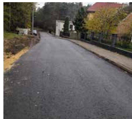
Przebudowa drogi dojazdowej do gruntów rolnych w miejscowości Kamiennik
