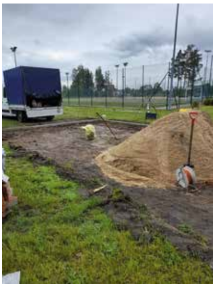
Budowa wiaty drewnianej w Chełście
