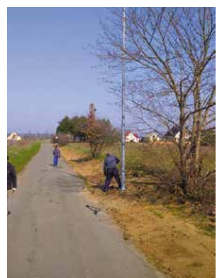
Budowa oświetlenia ulicznego w Kawczynie
