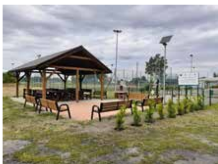
Budowa wiaty drewnianej w Chełście
