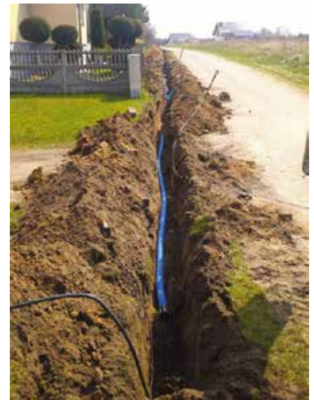
Budowa oświetlenia ulicznego w Kawczynie
