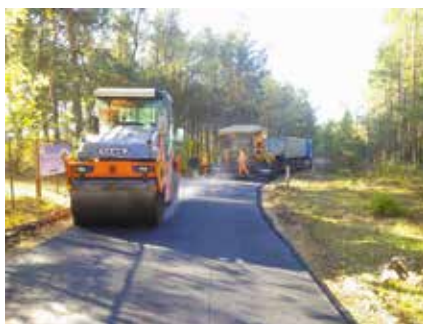
Przebudowa drogi dojazdowej do gruntów rolnych w miejscowości Kwiejce Nowe
