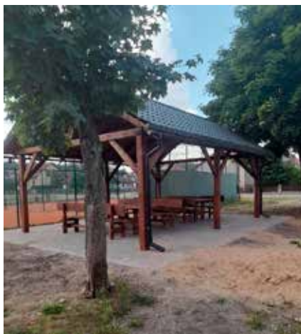
Budowa wiaty drewnianej w Drawskim Młynie
