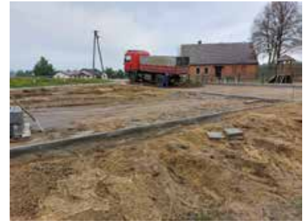
Budowa chodnika i parkingu w Kawczyń
