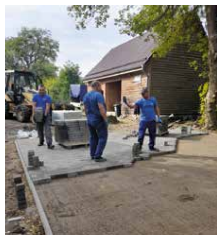
Układanie kostki brukowej pod wiatę w Marylinie
