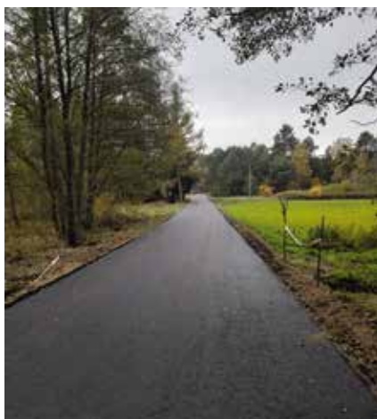
Przebudowa drogi dojazdowej do gruntów rolnych w miejscowości Kwiejce Nowe
