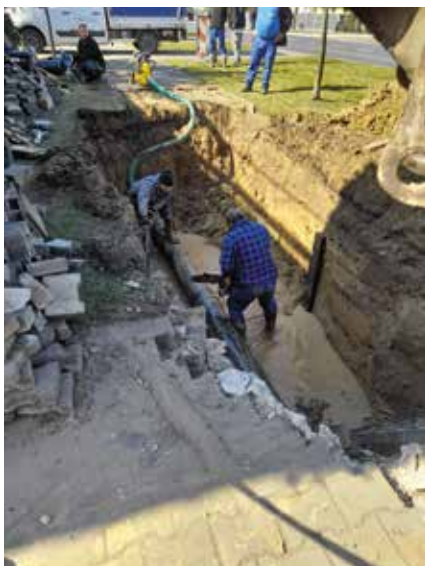
Usuwanie awarii na sieci wodociągowej w Drawsku na ul. Powstańców Wlkp.
