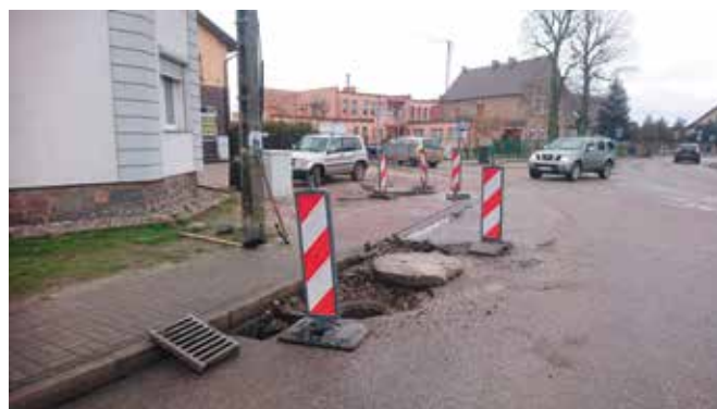
Usunięcie awarii kanalizacji burzowej na drodze powiatowej w Pęcowie
