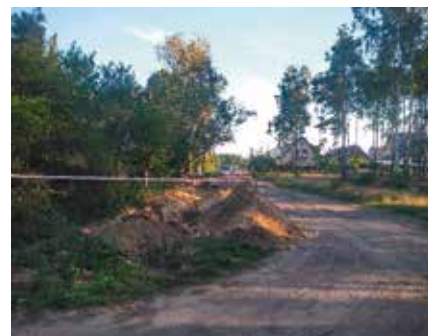
Budowa sieci wodociągowej w Drawskim Młynie ul. Kopernika
